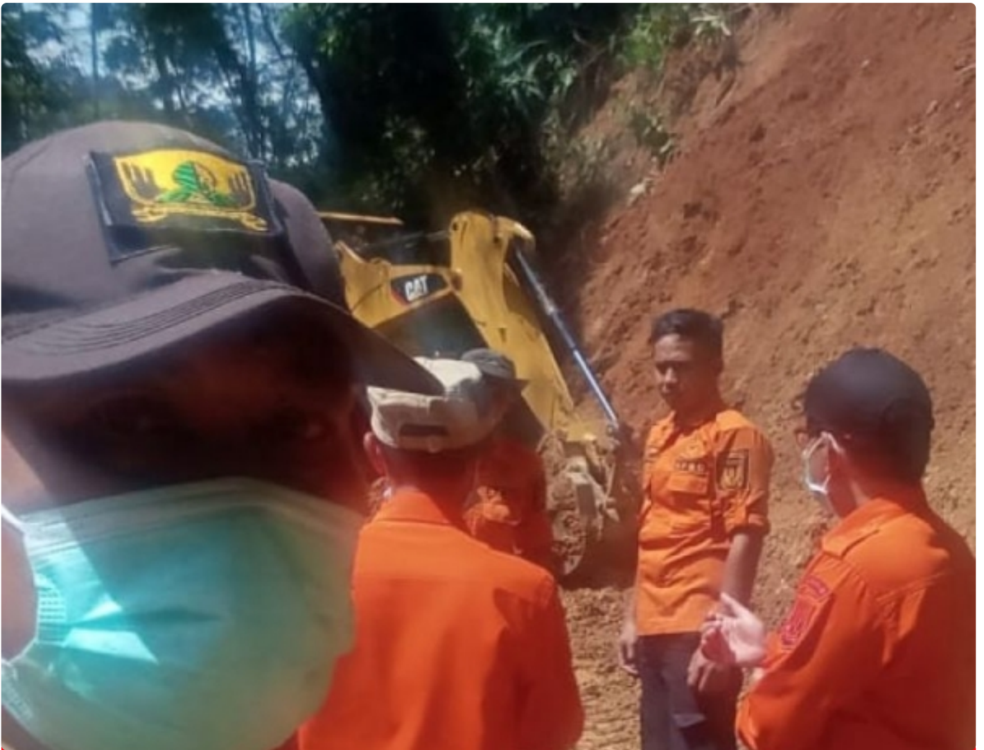
Sekmat Cisolok Bantu Evakuasi Material Longsor di Desa Gunung Tanjung
